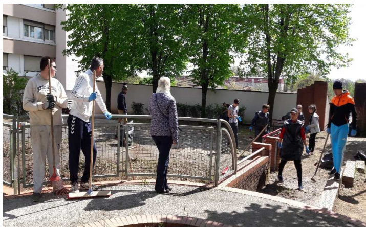
Chantier éducatif d'insertion professionnelle à Luxeuil-les-Bains
